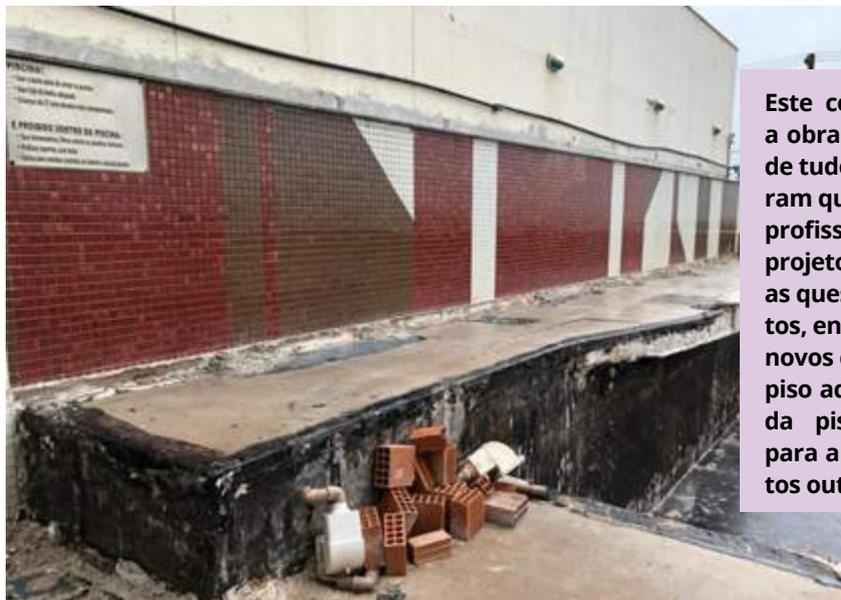
Este condomínio começou a obra sem projeto, depois de tudo quebrado entenderam que precisavam de um profissional para fazer um projeto que solucionasse as questões de revestimentos, encontros de materiais novos com os já existentes, piso adequado para o deck da piscina, revestimento para a piscina, dentre muitos outros.
