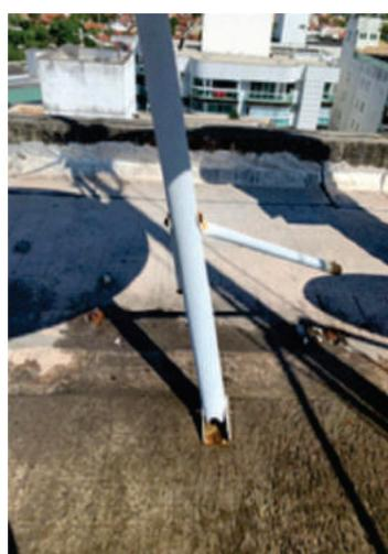
Figura 3- Antena solta com manta curada.
