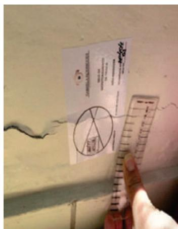
Figura 2- Trinca higroscópica
